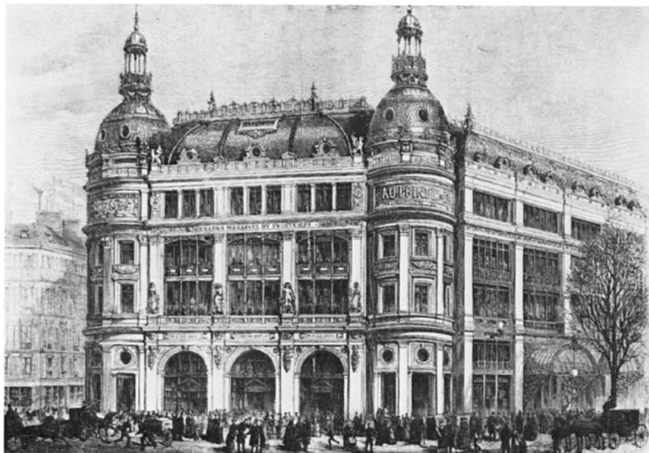
Figure 3.5. Au Printemps renovated exterior (Clausen, 1984, p.20)
